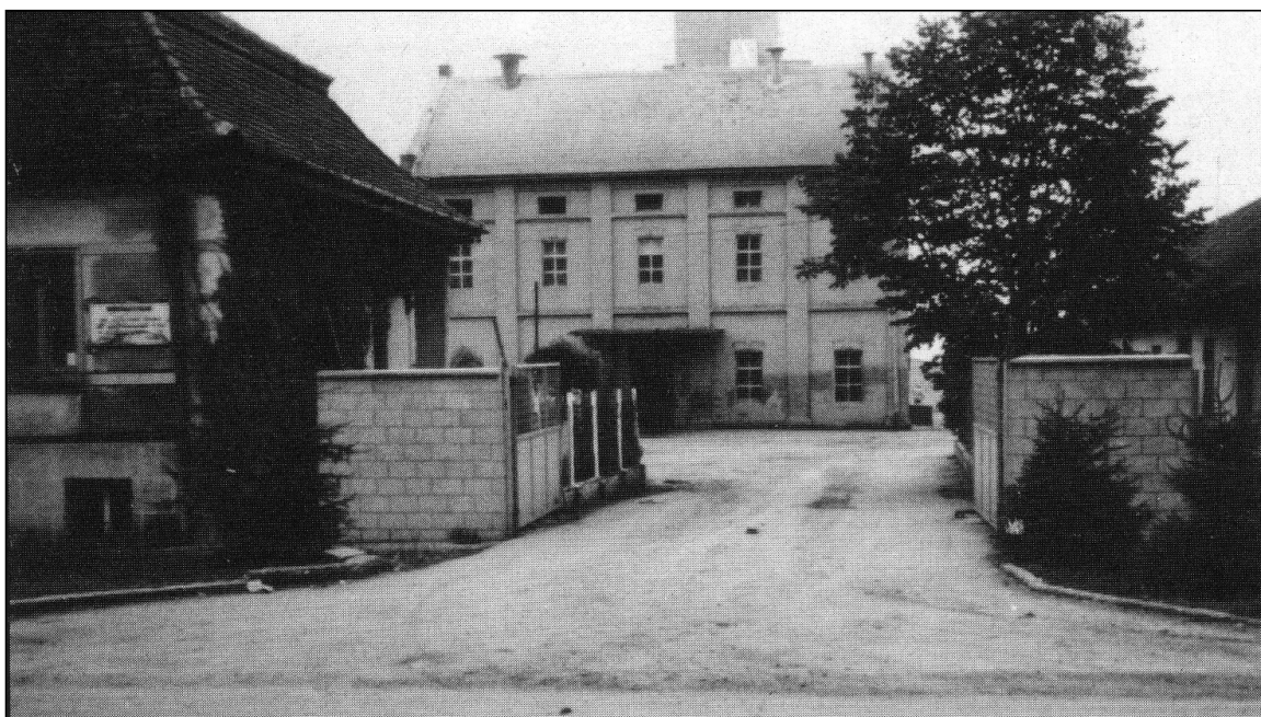
Ansicht der Getreidemühle; die Abbildung stammt aus den sechziger Jahren; im Vordergrund links: das nun ganz verwahrloste Wohnhaus der früheren Mühlenbesitzer Georg und Karola Birg; in dem niederen Gebäude rechts wohnte der Obermüller Nikolaus Gerger (Bild unten)
